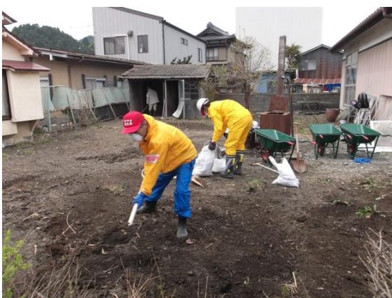
■被災家屋の庭でヘドロ掃除を行う
