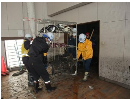
■相馬での体育館の片づけ作業。壁の汚れの高さまで津波が押し寄せた（4/20）
