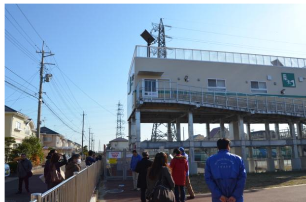
仙台市の岡田地区にて。災害時に備え、食料等も常備した「津波避難タワー」が各所に建設されています。
